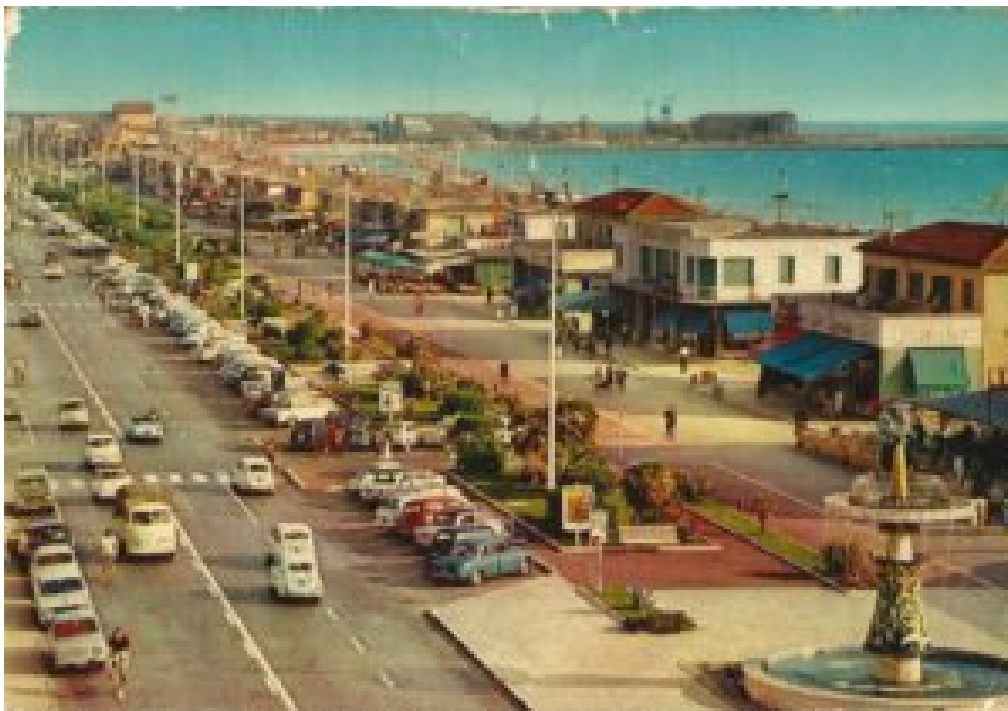
un'immagine del Lungomare viareggino in pieno boom economico: sullo sfondo, i cantieri della Darsena
